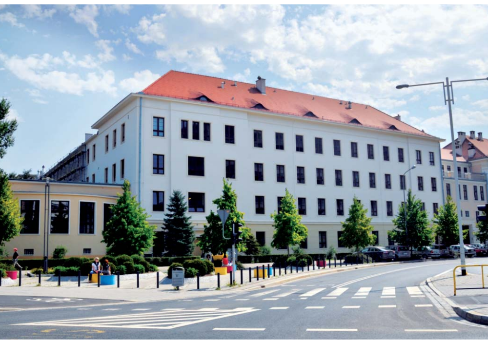
Budynek Wydziału Medycyny Weterynaryjnej przy ul. Norwida
